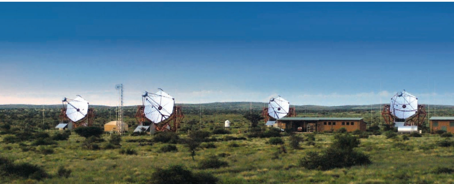
Die vier H.E.S.S.-Teleskope in Namibia. Jedes Teleskop verfügt über eine Spiegelfläche von 107 \text{ m}^2 .
