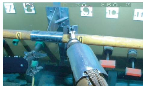
Oben: Bemanntes U-Boot „Nautil“ kurz vor dem Einsatz; Unten: Verbinden eines der Strings mit der „Junction Box“.
